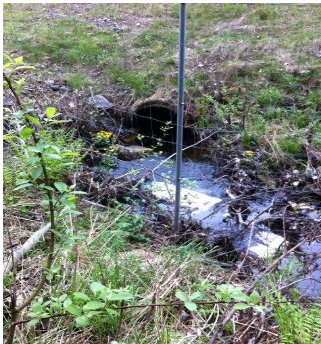
Bild3: Dike under E18.
