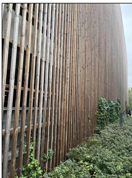
Bild: Inspirationsbild från Ladugårdsängen, Örebro kommun. Ribbpanel och grönska förskönar upplevelsen av ett parkeringshus.
