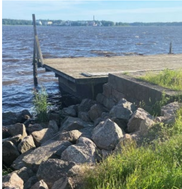
Foto: Den gamla kolbrygga består av ett betongfundament med en brygga av trä- och stålbalkar.
