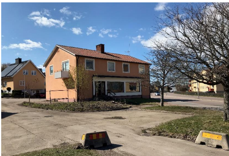
Kopplingen mellan Västra Ringvägens GC-bana och Nordenfeltsgatan.
