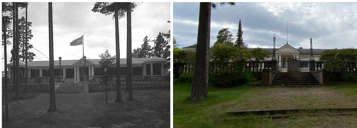
Serveringspaviljongen (förskolan) med omgivande mur.
