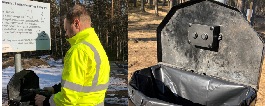
Installationen av sensorer har påbörjats! Sådär ser sensorn i papperskorgarna ut.
