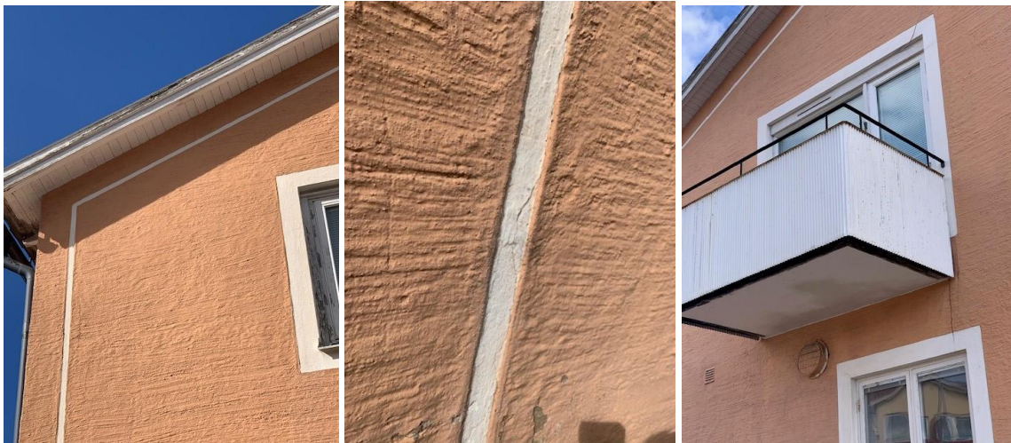
Den borstade putsfasaden med dekorrand och t.h. balkong i ursprunglig utformning.
