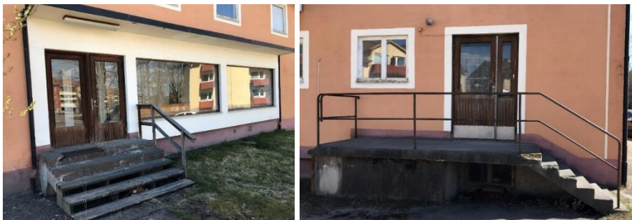
T.v. ursprunglig entré och fönsterparti. T.h. ursprunglig entré, trapp och räcke i smidesjärn.
