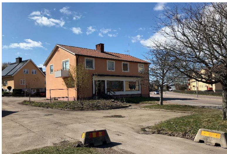
Kopplingen mellan Västra Ringvägens GC-bana och Nordenfeltsgatan.
