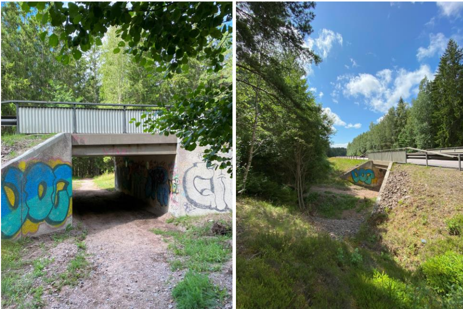
Figur 3-23. Norra vägporten (Vägport 2) (Foto: Sweco).
