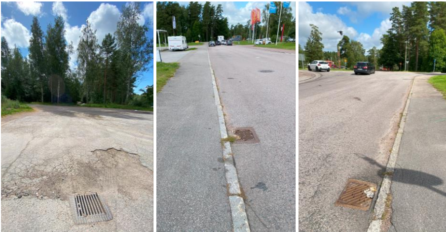
Figur 3-19. Befintliga rännstensbrunnar för avvattning vid Bodalsvägen. Höger: Rännstensbrunn vid infarten mot Harberget. Mitt och vänster: Längst med Bodalsvägen i riktning mot befintlig korsning. Motsvarande rännstensbrunnar finns på andra sidan vägen (Foto: Sweco).
