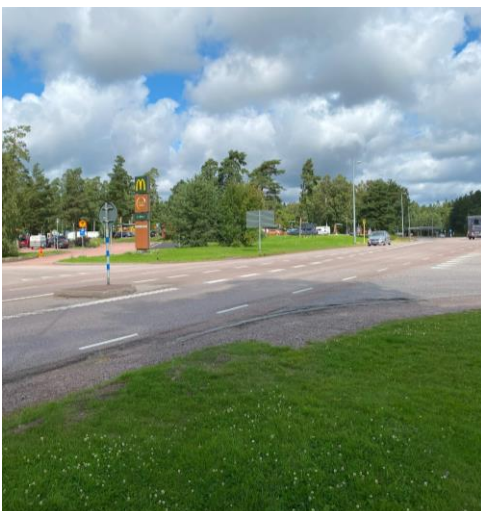
Figur 3-3. Befintlig fyrvägskorsning tagen sydväst om korsningen i norrgående riktning (Foto: Sweco).
