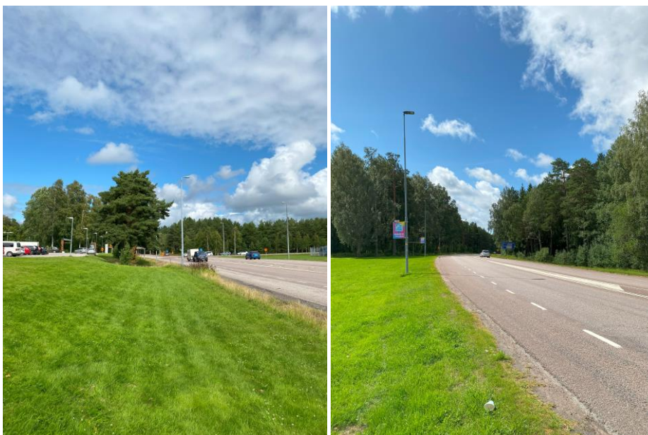
Figur 3-18. Diken/grönyta för avvattning på båda sidor av Väg 26. Höger – nordöst om befintlig korsning i riktning mot norr. Vänster – sydväst om befintlig korsning i riktning mot söder (Foto: Sweco).
