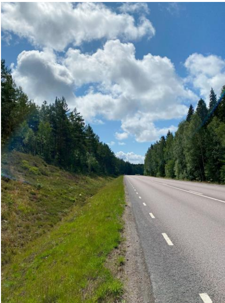
Figur 3-30. Vägdike öster om Väg 26 mellan Vägport 1 och Vägport 2 (Foto: Sweco).
