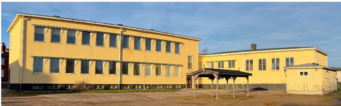
Den gula byggnaden sedd från sydväst med gymnastiksalens förrådsutbyggnad synlig till höger i bild.
