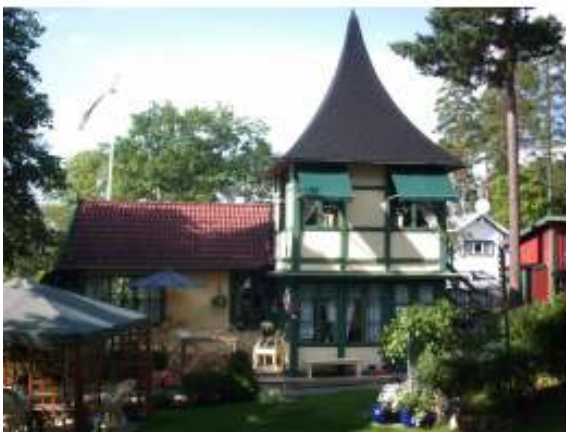
Skansen boningsvilla "Sockertoppen", med sitt karaktäristiska torn likt en svart filthatt.
