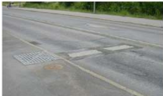
Dynamiskt fartgupp. Balk höjs upp om fordon kör snabbare än t.ex 30 km/h (Bild från: Stockholms lokaltrafik)
