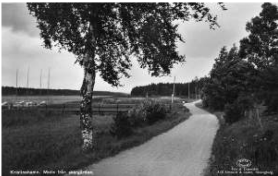
Vålösundsvägen i början av 1900-talet med en karaktär av dagens gång- och cykelbanor.
