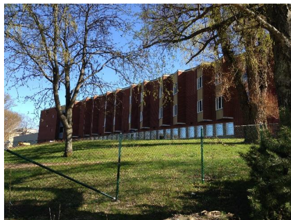
Foto: Vårdbyggnaden för rättspsykiatri norra fasad.
