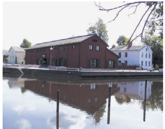
Mastmagasinet, gamla hamnen.
