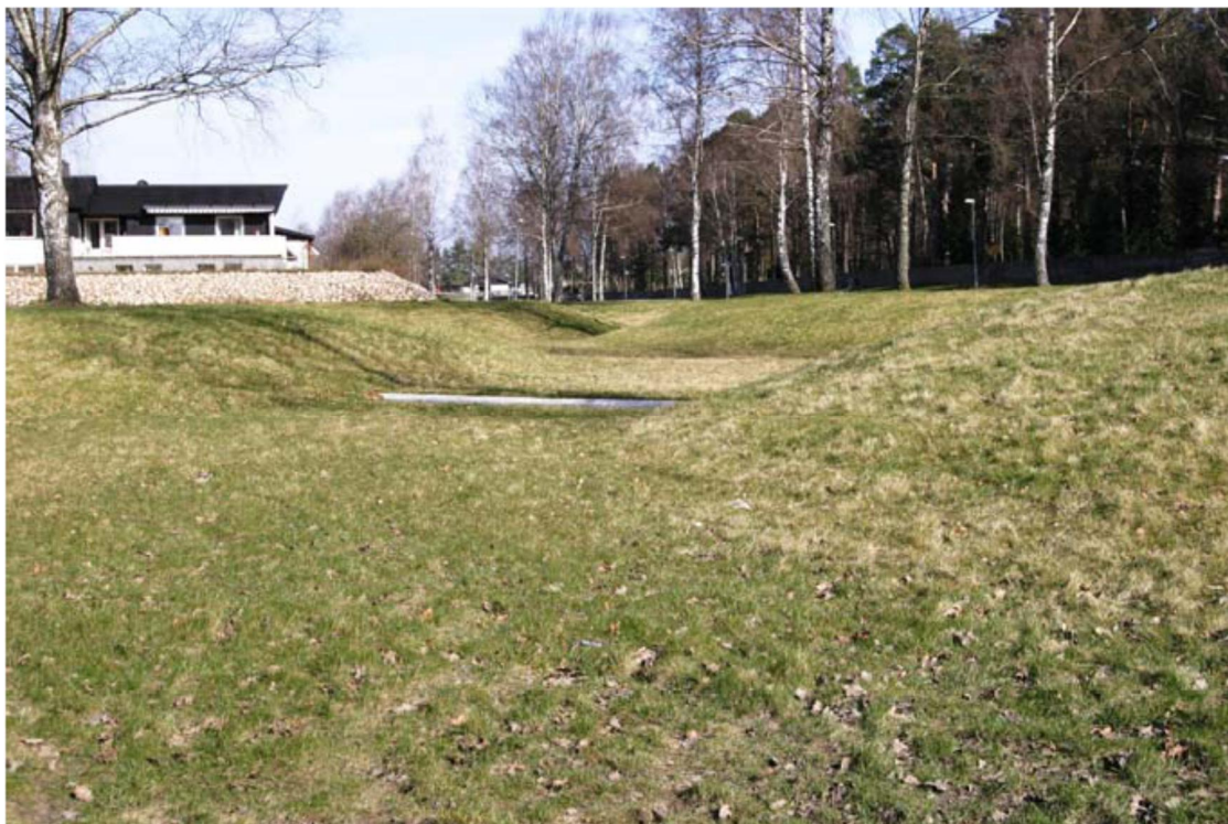
Bild 4. Exempel på utformning av en s.k. torr utjämningsmagasin
