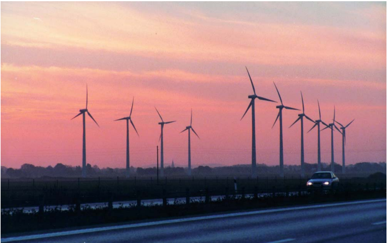
Vindkraftverk längs E6 utanför Falkenberg i Halland är ett exempel på en lyckad placering av kraftverk i grupp.
