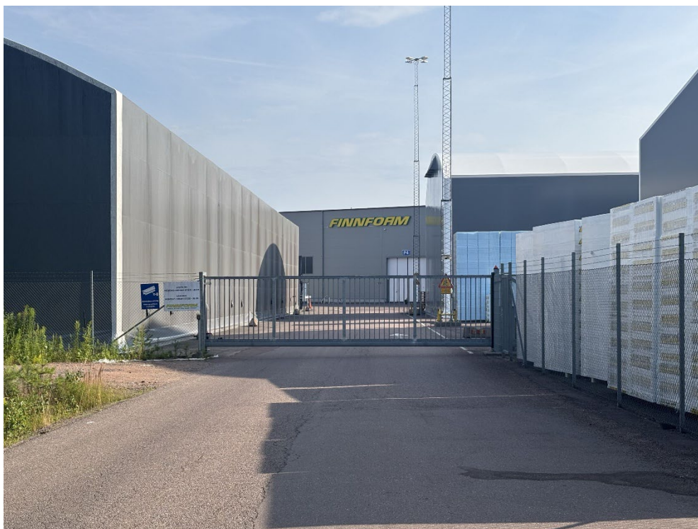
Figur 5 Foto som visar den nuvarande grinden hindrar infart på industrigatan.
