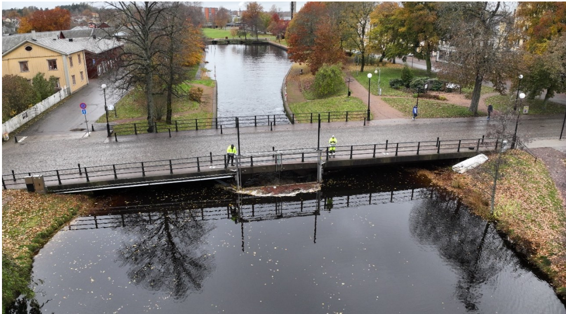
Figur 3.3. Vågbron, utskovslucka observerad från uppströms sida.
