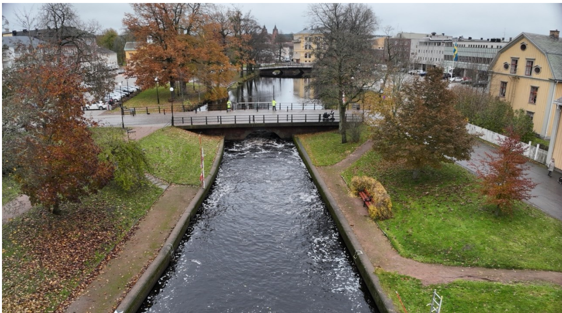
Figur 3.2. Vågbron observerad från nedströms sida. Kungsbron ses i bakgrunden.
