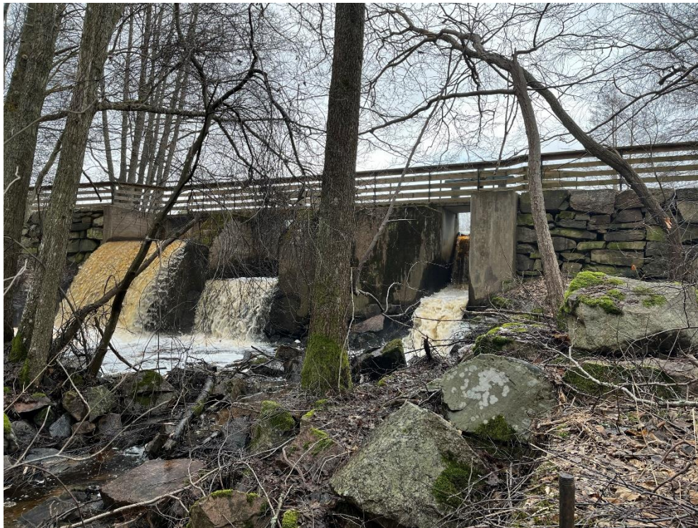
Figur 5 Dammluckor på uppdamningen vid utloppet av Kvarndammen.
