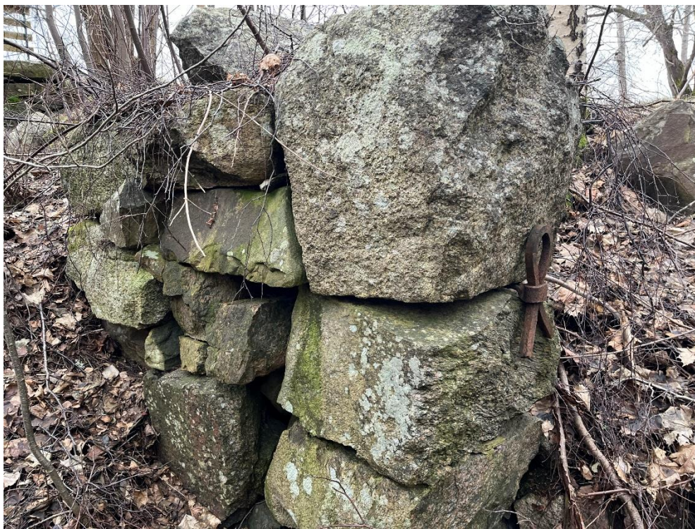
Figur 23 Stenfundament med bindjärn, kvarlämningar från Herrekvarn vid Kvarnbacken. Foto 2024.
