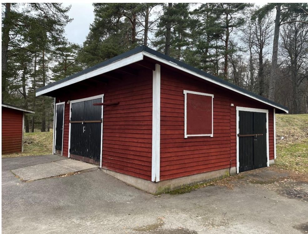
Figur 26 Servicebyggnad från den före detta Kvarndammens camping. Foto 2024.
