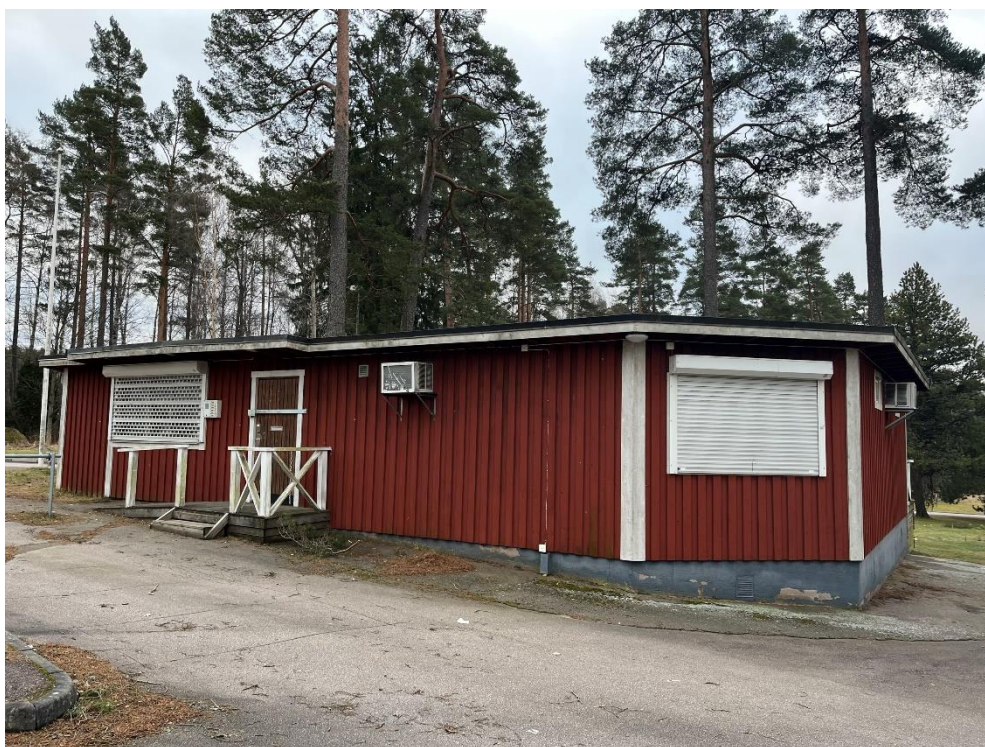
Figur 24 Receptionsbyggnaden vid Kvarndammens före detta entré. Numer föreningslokal för veteranbilsföreningen Nostalg & nutid. Foto 2024.
