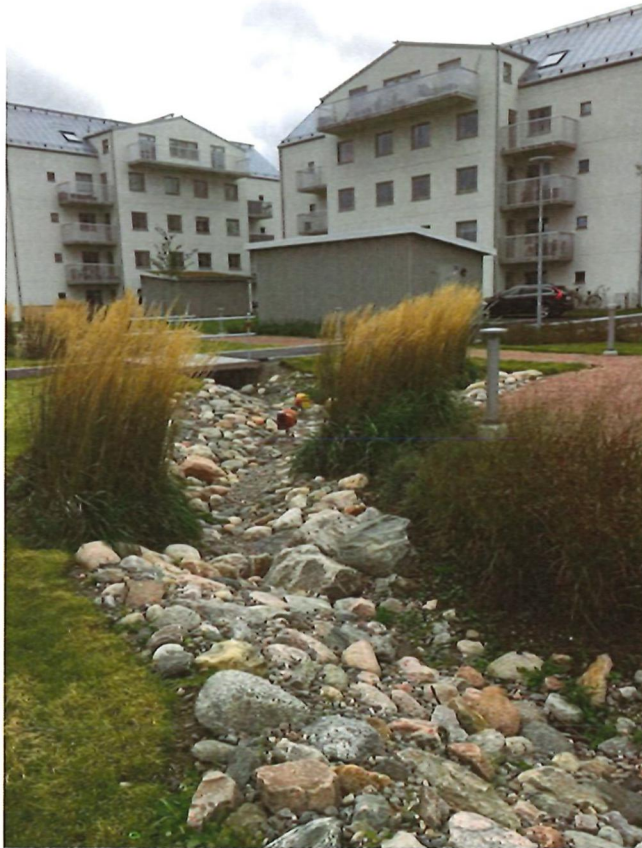
Bild: Regnrabatter vid parkeringsyta, ett effektivt och visuellt tilltalande sätt att ta hand om dagvatten.
