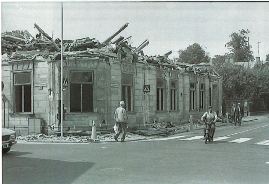
Foto: Byggnad i hörnet Västerlånggatan/Tegelslagaregatan. Ett rivningslov lämnades in till kommunen 1972. (Källa: Kristinehamns bildarkiv)
