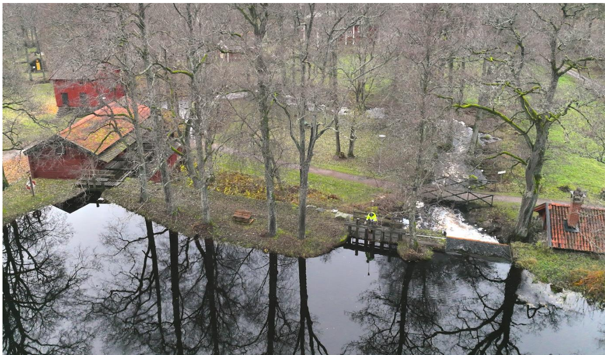
Figur 5.5. Smedby kvarn, där kvarn och kvarnintag syns till vänster i bild. Reglerdamm med luckutskov och skibord syns till höger. Bilden är tagen i strömriktningen.
