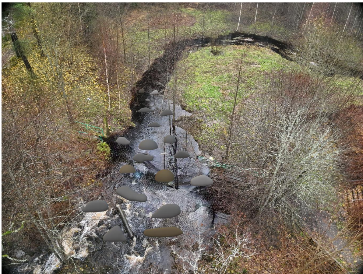
Figur 7.8. Principskiss av damm uppströms Herrekvarn. Bottenuppbyggnad kommer att ske cirka 30 meter nedströms, och cirka 50 meter uppströms dammläget. Dammen är på bilden borttagen, men de gröna räckena och anslutande gångväg är synliga.
