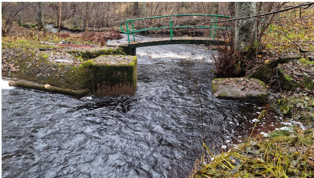
Figur 5.8. Dammrest sett i strömriktningen.
