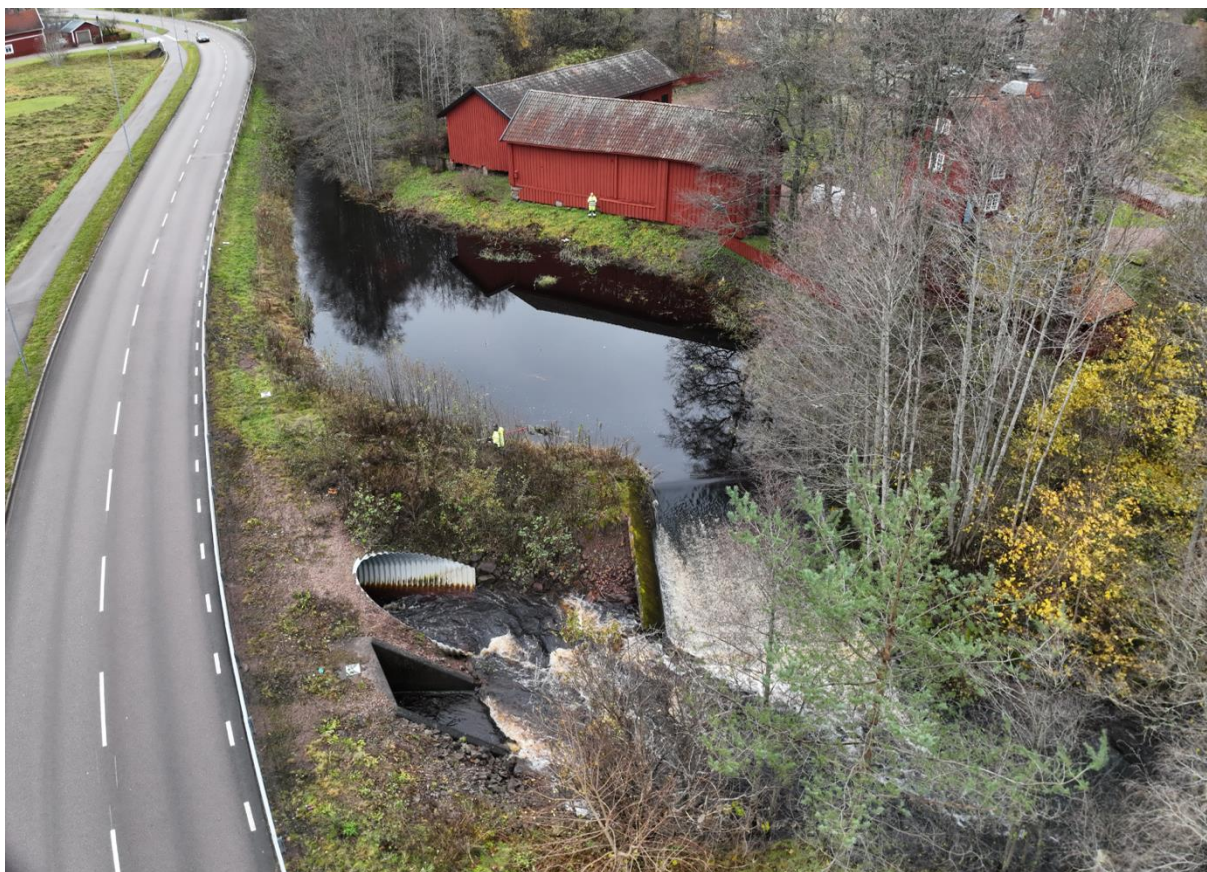
Figur 5.3. Björklundsdammen sett i uppströmsriktning. I bilden ser man den uppdammda vattenspegeln i Övrekvärnsälven. På bilden ser man här att Varnan och Övrekvärnsälven möts strax nedströms dammen. Varnan rinner här under Östra Ringvägen genom en trumma och en kulvert.
