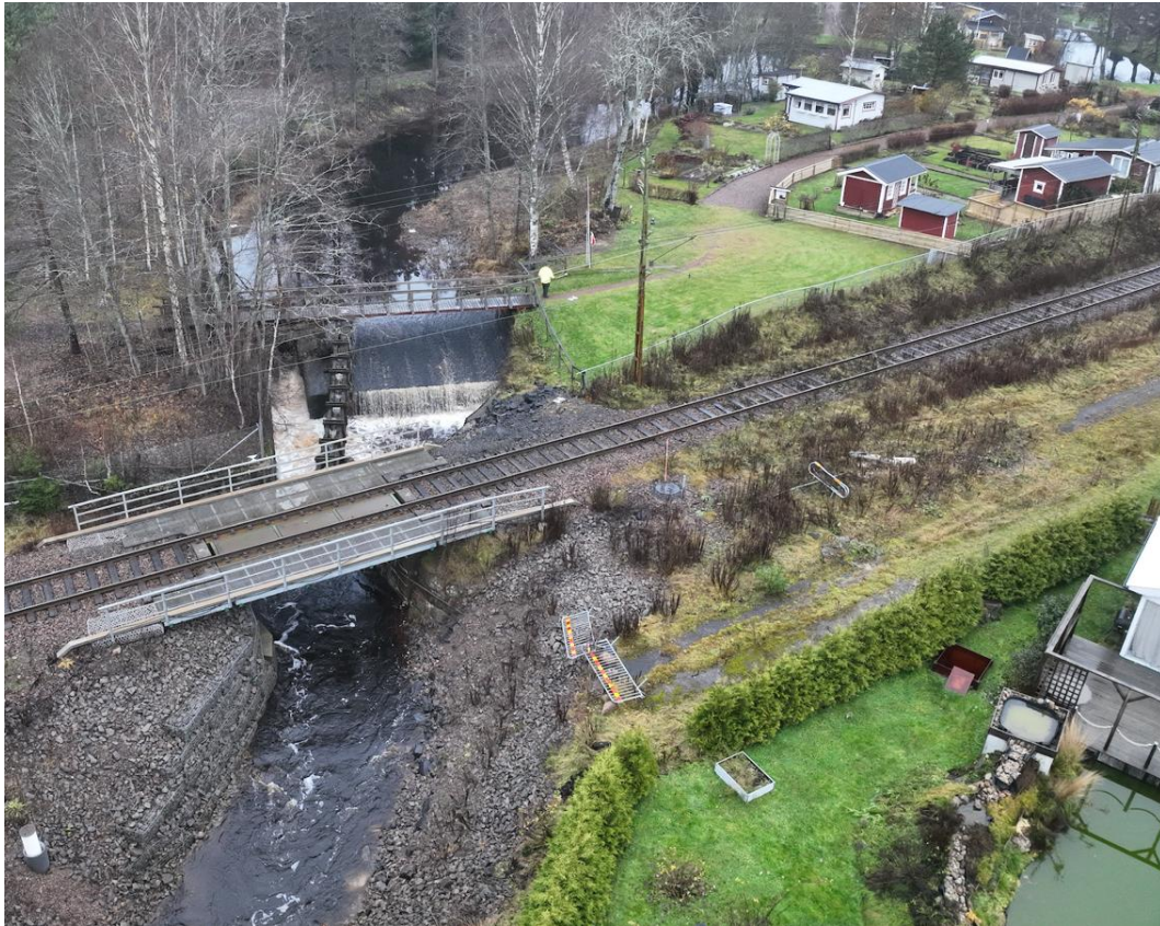
Figur 5.2. Hagadammen sett från nedströmssidan.
