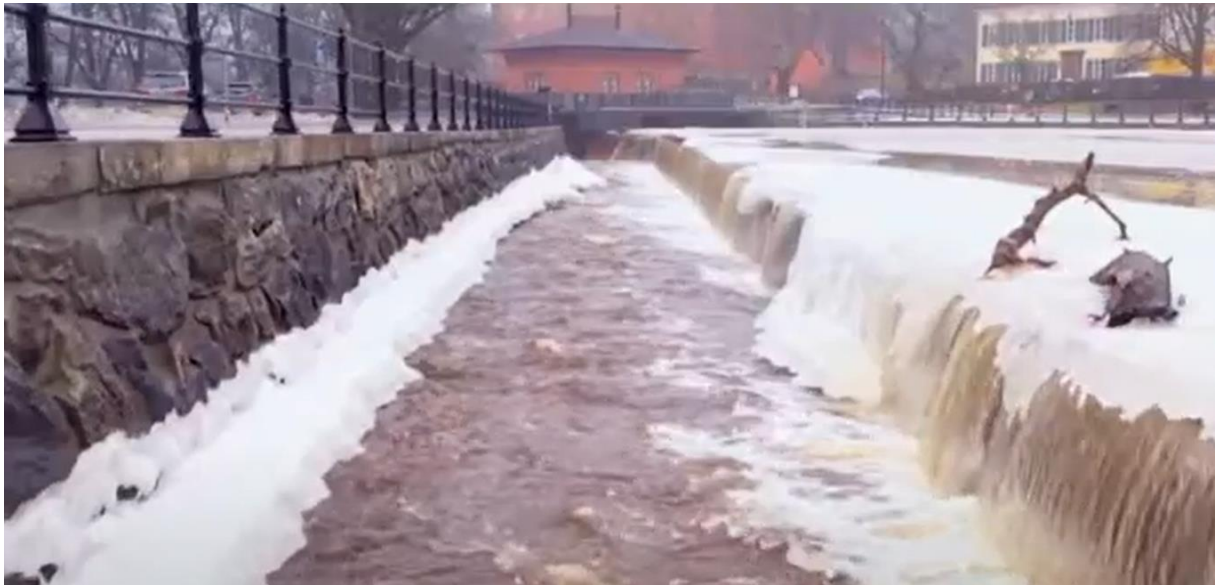
Figur 7.1. Turbinbron, Västerås. Trots stora mängder is flödar vattnet fritt över skibordet. Foto: skärmbild från Mälarens vattenvårdsförbunds hemsida.
