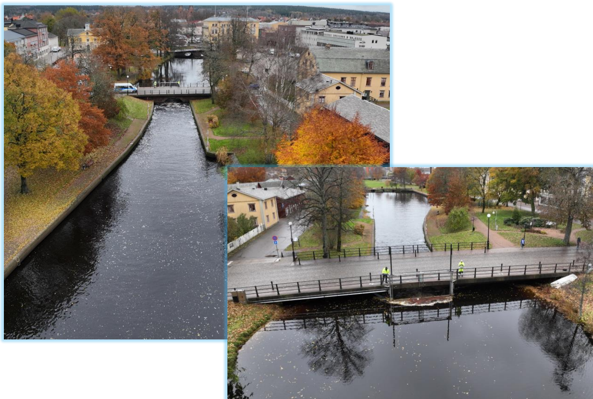
Figur 5.1. Övre bilden visar Vågbron från nedströmssidan. Nedre bilden är tagen från uppströmssidan, öutskovsluckan syns centralt i dammen/bron.
