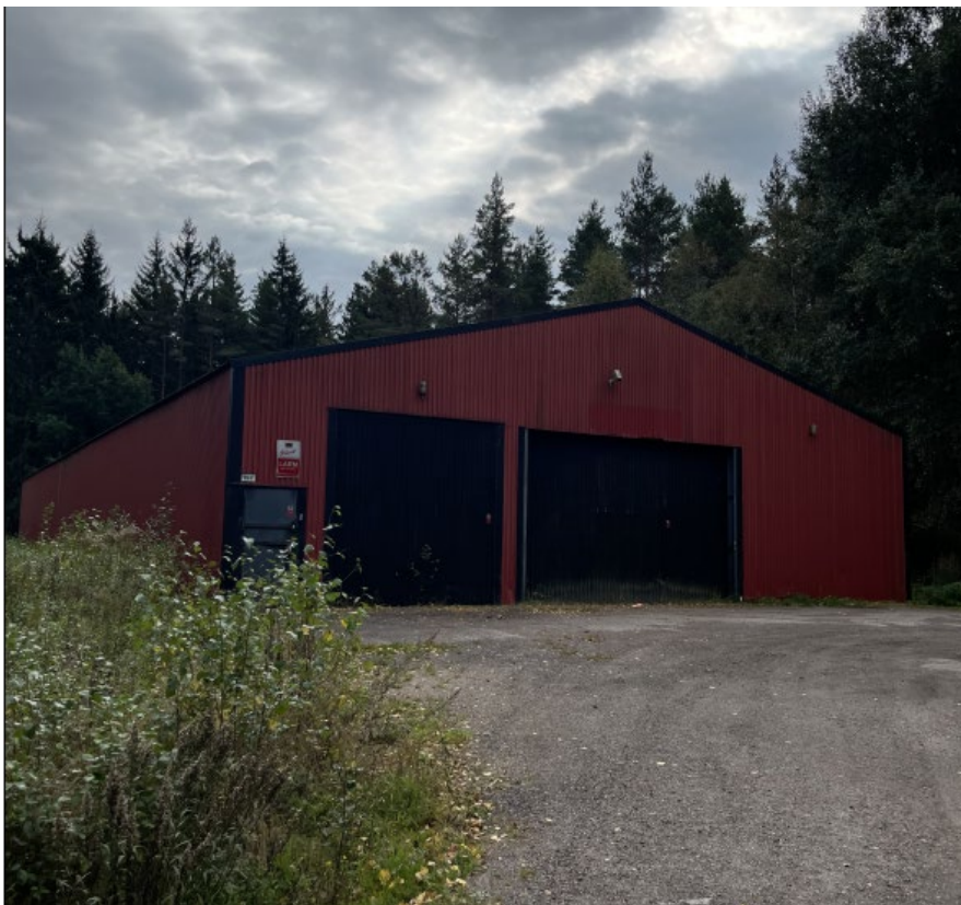
Foto: Befintligt kallförråd.
