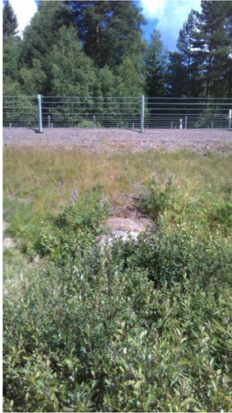
Foto: BTG1000 under E18. Rensning av sly vid inloppet bör säkerställas (Foto: Kristinehamns kommun, juni 2023). Dagvattenutredning A9, Harberget Kristinehamn Fortifikationsverket, Sweco 2023-08-29.
