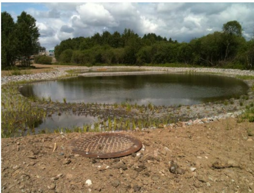
Foto: Exempel på dagvattendamm med vattenspegel längs med E18 (Foto: Sweco). Dagvattenutredning A9, Harberget Kristinehamn Fortifikationsverket, Sweco 2024-06-26.
