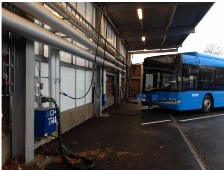
Bild 3. Exempel på skärmtak för bussparkering från Västtrafiks bussdepå i Trollhättan. Under skärmtaket har bussarna även möjlighet att göra mindre serviceåtgärder, tex fylla på spolarvätska, tanka och elbussar har möjlighet att laddas.
