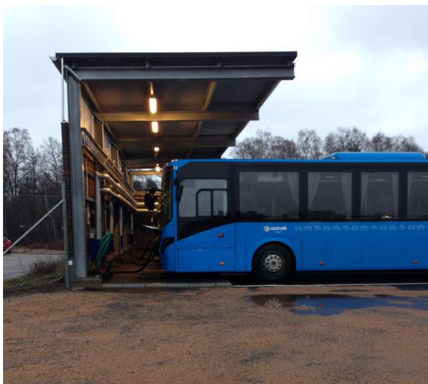
Bild 4. Exempel på skärmtak för bussparkering från Västtrafiks bussdepå i Trollhättan.
