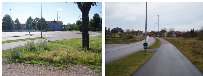
Bilderna visar korsningen mellan Östra Ringvägen och Dalavägen samt gc-vägen vid Östra Ringvägen.
