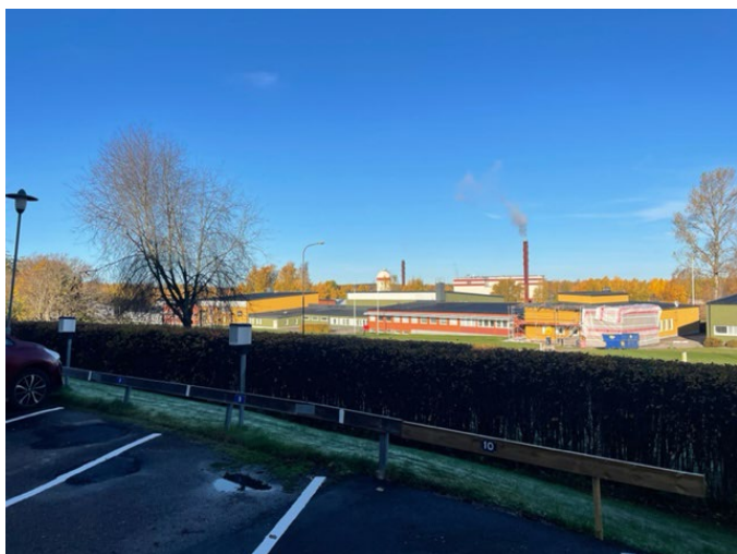
Foto: Värmeverket sett från Kv. Tigern
