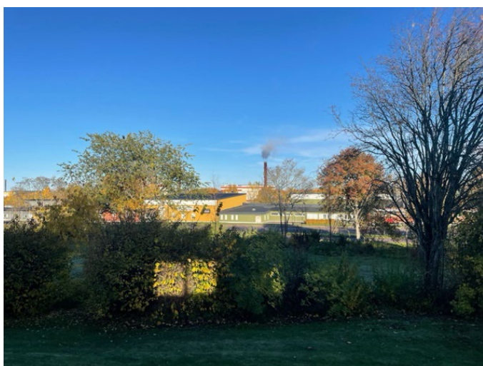
Foto: Värmeverket sett från Kv. Tigern.
