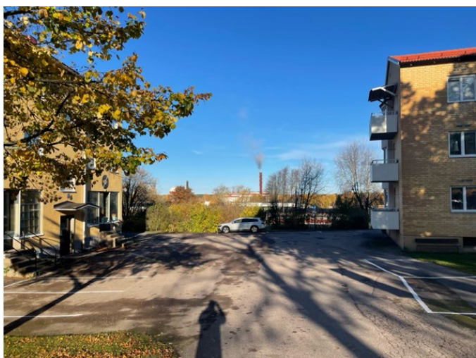
Foto: Värmeverket sett från Kv Tigern
