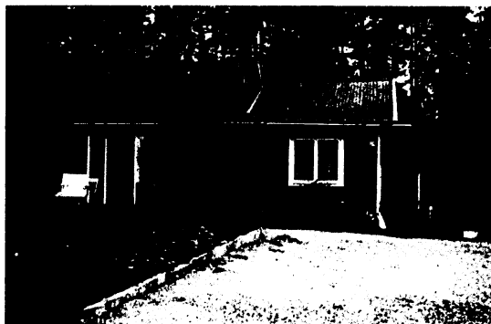
Exempel på vattengenomsläppligt ytmaterial: Grus och gräsarmering.
