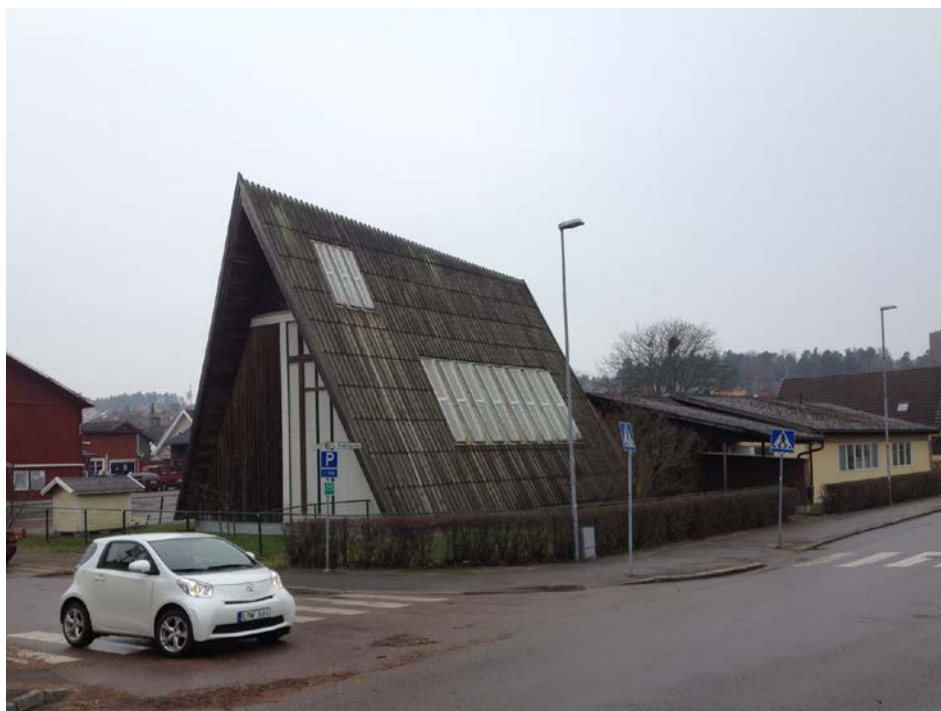
Foto: Fd Metodistkyrkan 2014-03-07 innan rivningen av kyrksalen
