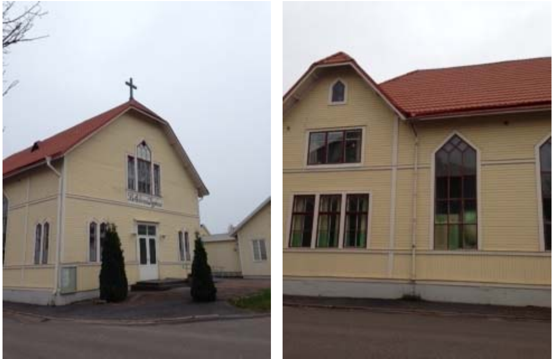
Foto: Kyrkobyggnadens entré samt fasad mot Östra Staketgatan. På bilden till höger syns de utbytta fönstren på andra våningen.
