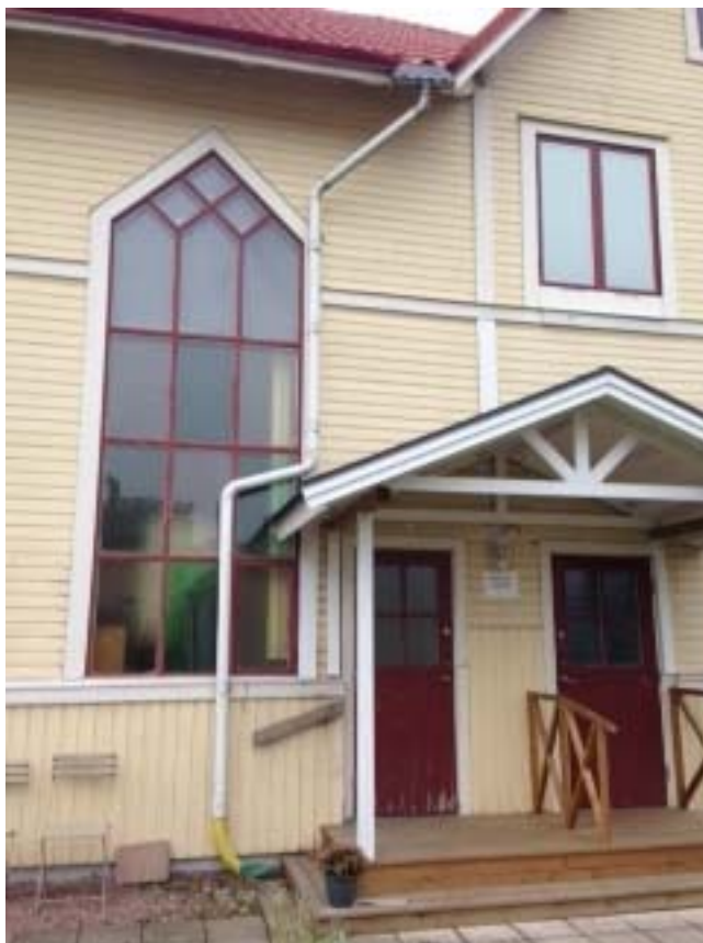
Foto: Kyrkobyggnadens gårdsentré. Nyare fönster på andra våningen.
